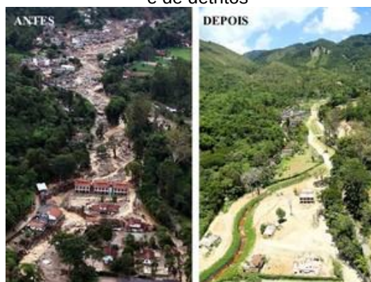
Figura 05 – Região serrana do Rio de Janeiro antes e depois das obras de controle de fluxos de água e de detritos
